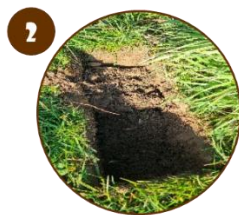
2 Bodenziegel / Rasenziegel ausstechen (ca. 10-15 cm tief)
